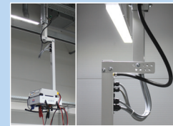
Die Spezialaufhängung mit integrierter Stromführung gewährleistet die gerade Montage der E-BOX.
